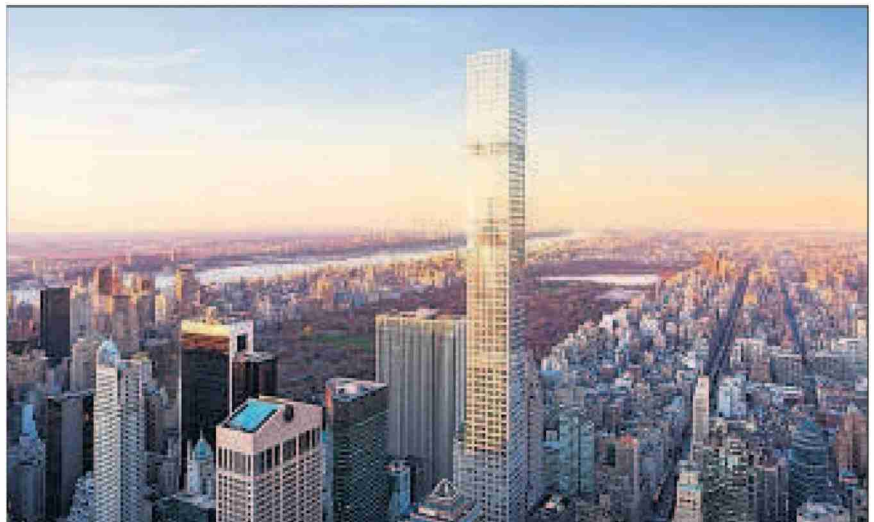
Herausragender Wohnturm. 432 Park Avenue in New York.
